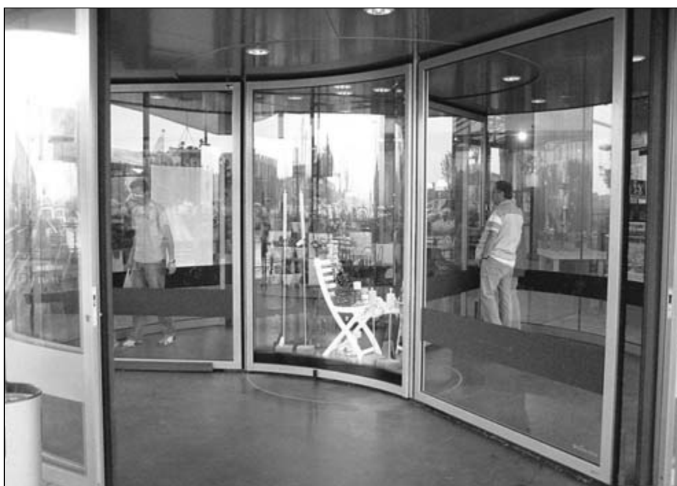
Met de geheel nieuwe ingang heeft de Intratuin in IJsselstein het laatste onderdeel van de grote verbouwing voltooid. FOTO: DIEDERIK HUFFELS
